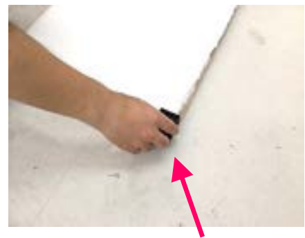
追加補充脚の貼り付け
