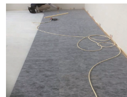
⑧ 施工 レンガ張り
