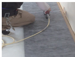
③ マットの固定 タッカー止め (目安 200mmピッチ)
